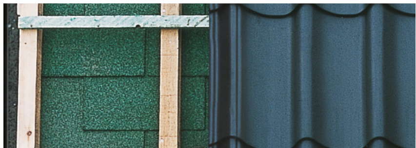
Renovierung auf Bitumenbahnen: Hier bietet sich die Dach-auf-Dach-Methode an.
